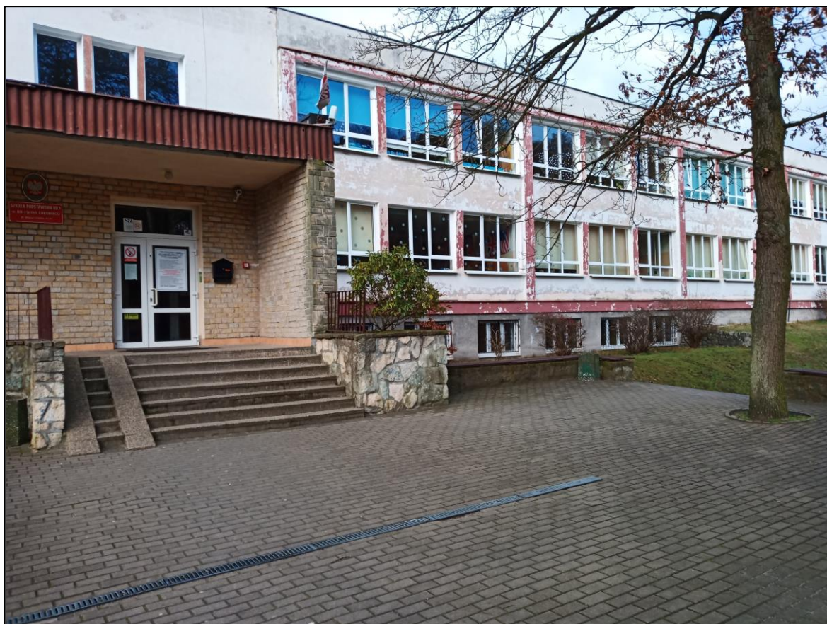
Ilustracja nr 20 - Budynek Szkoły Podstawowej Nr 1 w Międzyzdrojach wymaga termomodernizacji – źr.własne
