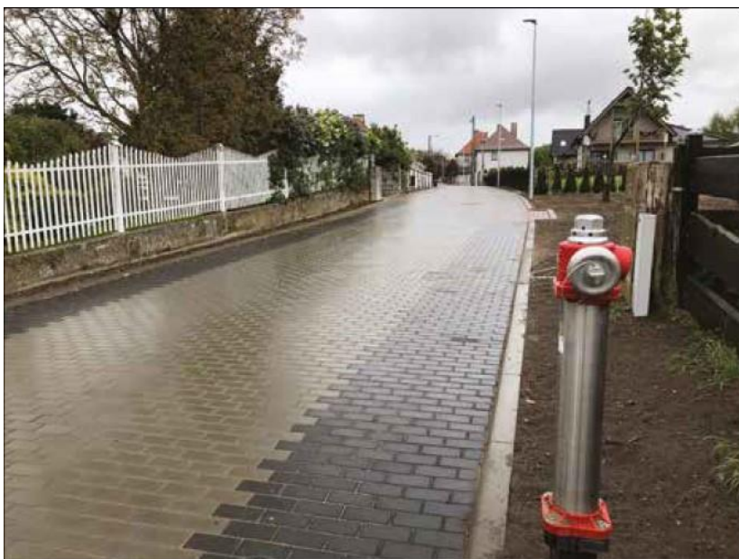
Ulica Boczna już przebudowana
