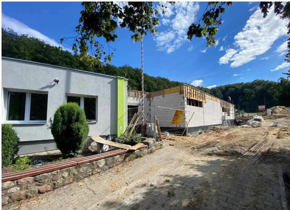
Ilustracja nr 12 Budowa hali w Wapnicy przy SP2 (źródło własne)
